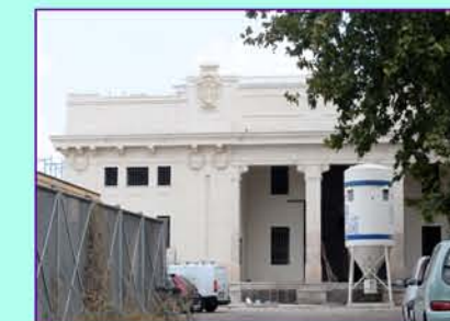
Edificio della Reale Dogana attualmente in restauro
